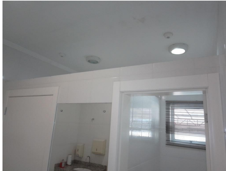
Foto 11 – Prolongamento de parede no banheiro masculino
