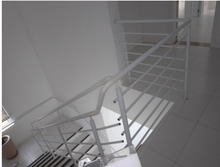
Foto 10 – Corrimão e Guarda-corpo da escada
