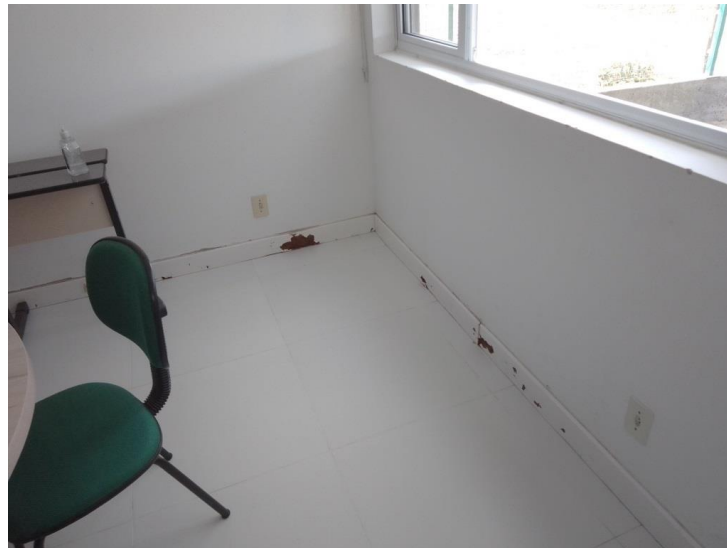
Foto 07 – Substituição de rodapés
