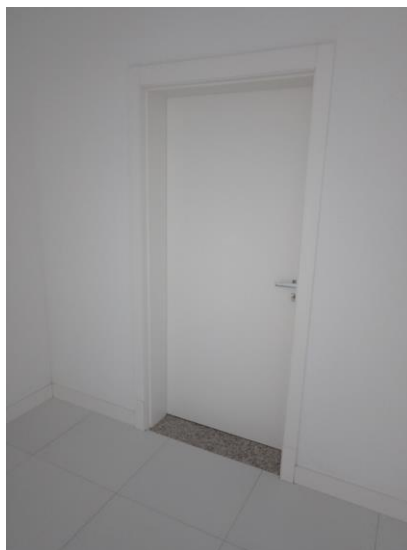
Foto 04 – Pintura de portas e rodapés
